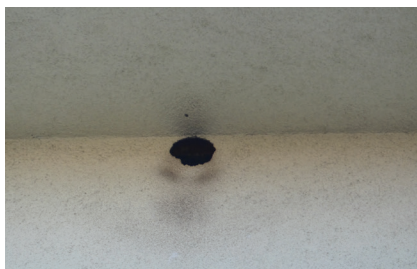
Obr. 5 a 6. Obsazené dutiny v zateplení lze často zjistit i podle typického ušpinění fasády vznikajícího otěrem různých částí těla hnízdicích ptáků při vstupu do dutiny. Brno, 26. 3. 2019. © K. Horák
