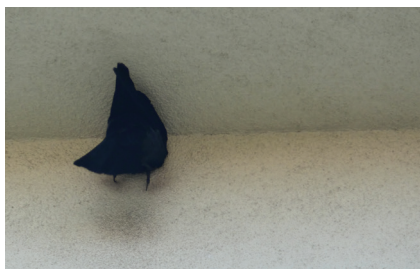
Obr. 5 a 6. Obsazené dutiny v zateplení lze často zjistit i podle typického ušpinění fasády vznikajícího otěrem různých částí těla hnízdicích ptáků při vstupu do dutiny. Brno, 26. 3. 2019. © K. Horák
