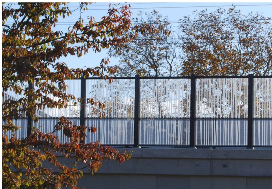
Zabezpečení železničního koridoru v Praze – Radotíně. Foto: G. Dobruská
