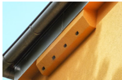
Nistkasten für Mauersegler an einem Wohnhaus
