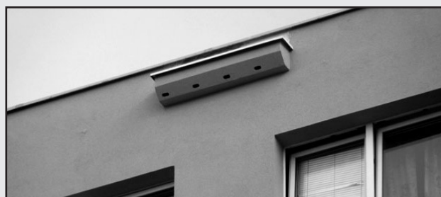
Polystyrenová budka, instalovaná ve vrstvě tepelné izolace, je až náhradní řešení.
